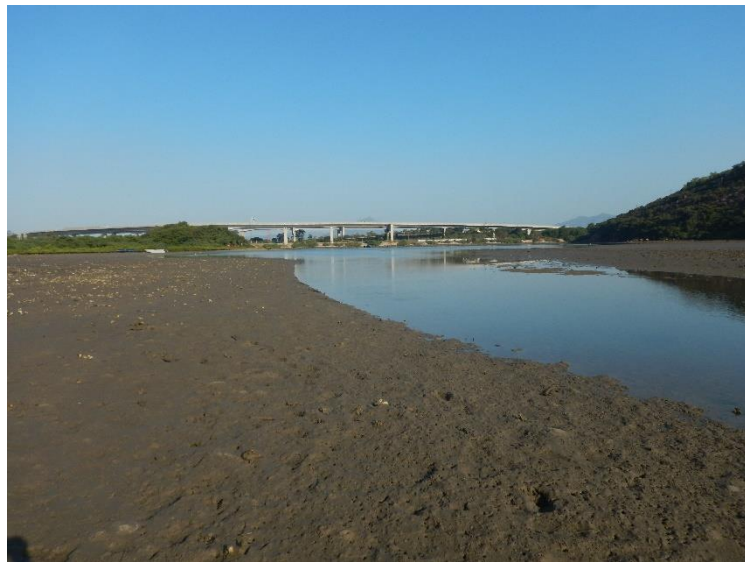
(d) Survey Location at THW
